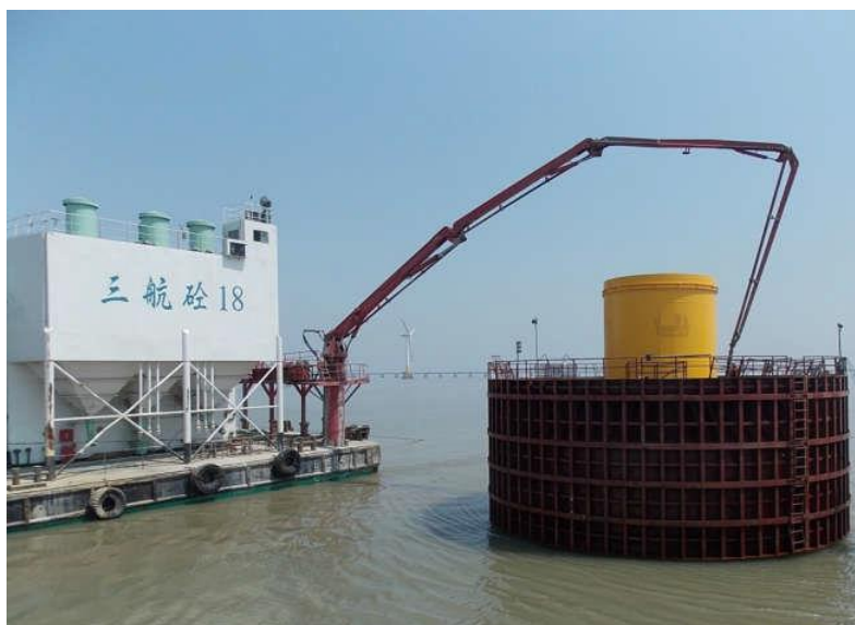
图 2.3-6 承台混凝土浇筑
