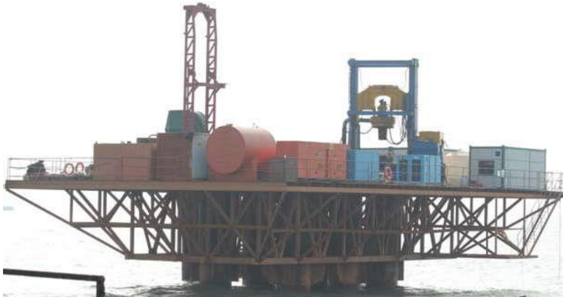
图 2.3-3 施工嵌岩平台搭设
